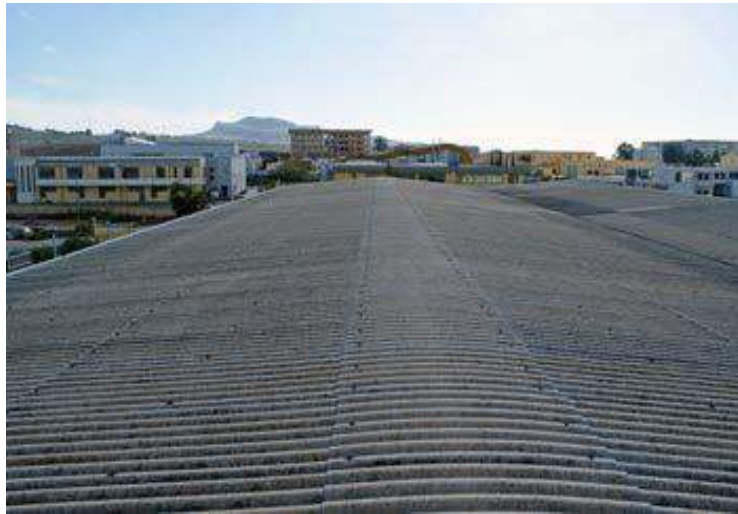
Figura 31: PRE-OPERAM (COPERTURA IN CEMENTO AMIANTO)
