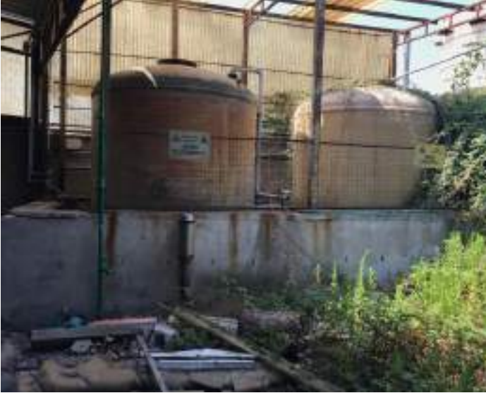
Figura 27: Serbatoi Acido cloridrico e Soda caustica
