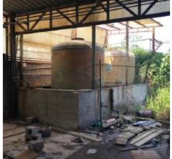
Figura 27: Serbatoi Acido cloridrico e Soda caustica
